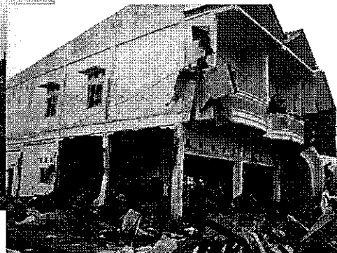
インドネシア Banda Aceh Collapsed building by Tsunami
